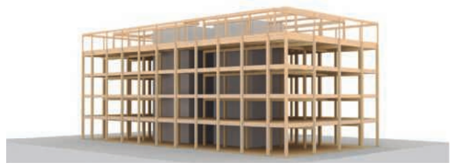
Le nouveau siège d'EGK mise sur la durabilité: l'édifice conçu par le cabinet d'architectes Flubacher Nyfeler Partner Architekten AG, avec sa façade et son ossature en bois, n'a utilisé le béton que pour sa structure, avec un bilan correspondant à 1082 tonnes de CO 2 .
