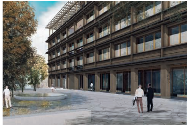
Le nouveau siège d'EGK mise sur la durabilité: l'édifice conçu par le cabinet d'architectes Flubacher Nyfeler Partner Architekten AG, avec sa façade et son ossature en bois, n'a utilisé le béton que pour sa structure, avec un bilan correspondant à 1082 tonnes de CO 2 .
